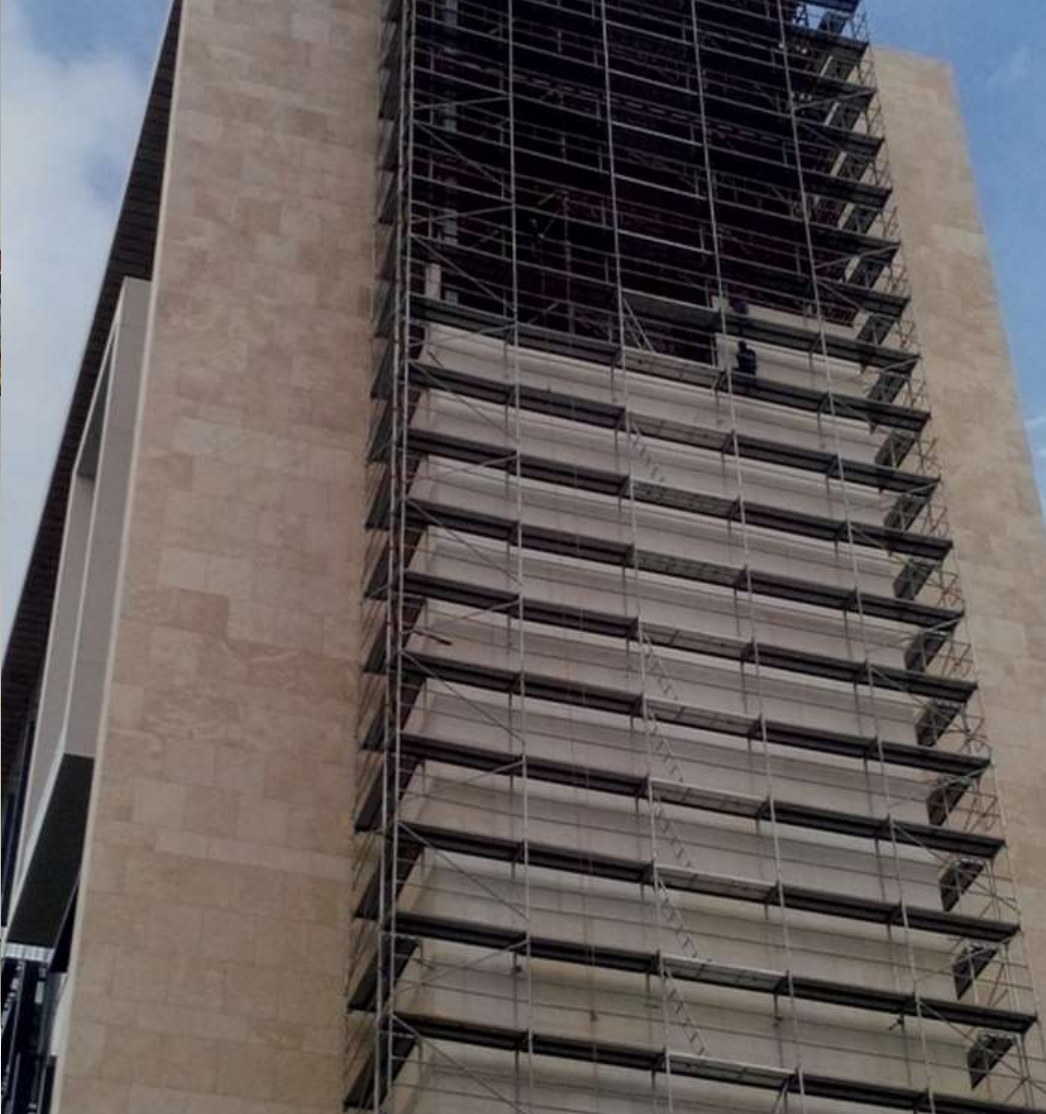
OfisPark Yangın Merdivenleri
